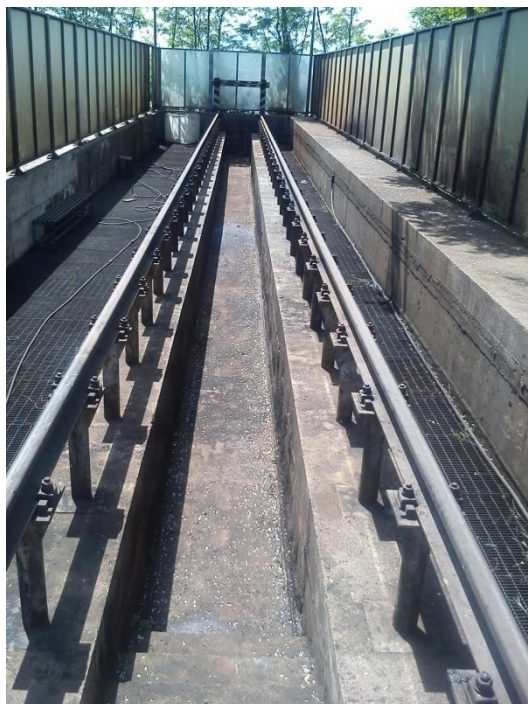
Figura 5: Buca esterna di lavaggio dell'officina di Piedimonte Matese
